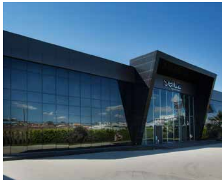
Selüz Kimya Fabrikası - Kocaeli
